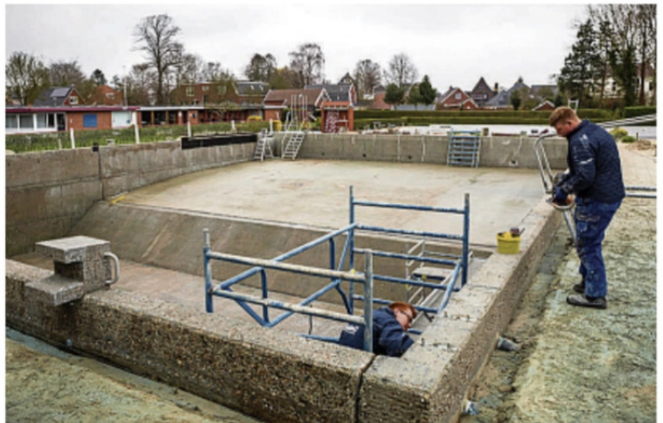
De Ringberg in Scheemda krijgt een nieuwe coating. FOTO: HUISMAN MEDIA
