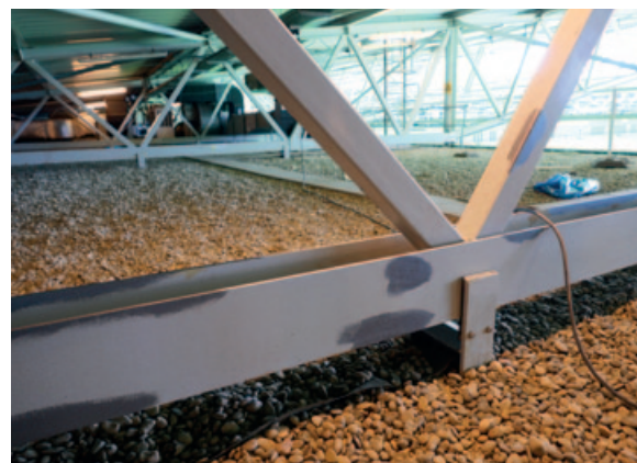
Bijgeplekte delen die eerst corrosievrij zijn gemaakt
