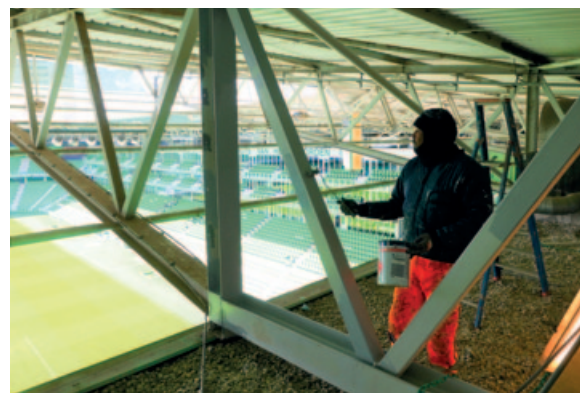
Als SealteQ het conserveringsproject in oktober 2022 afrondt, kan het staalwerk zeker weer vijftien jaar vooruit
