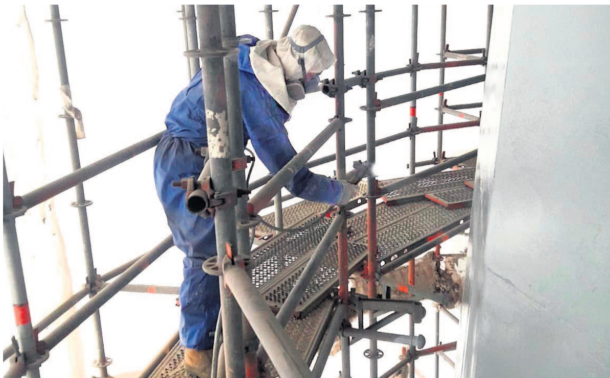
Het stralen en conserveren van twee gietijzeren vuurtorens is voor SealteQ Noord een primeur
